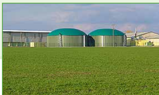
Μονάδα βιοαερίου 3MW. Φωτ: www.prenecon.com
